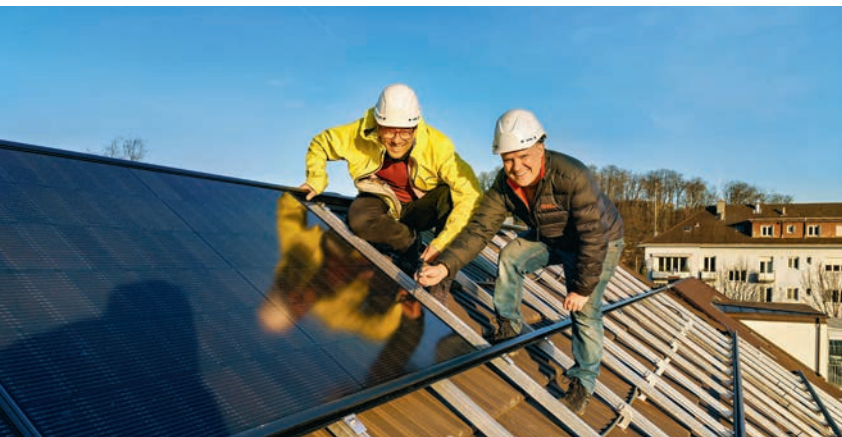
Ein Gemeinschaftswerk von Miteigentümer Tobias Oetiker (in gelber Jacke) und Solarprofi Martin Blapp (Bauleiter) sowie Familie und Genossenschaft. Pizzen und ausführliche Berechnungen der Kabellängen gehören dazu.
