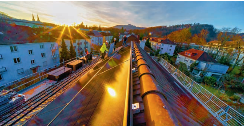
Die Arbeiten auf dem Dach des Generationenhauses in Olten gehen bei unserem Besuch an einem Samstag im Februar mit wenigen Abstimmungsproblemen gut voran – wenige Tage danach steht die Anlage.
